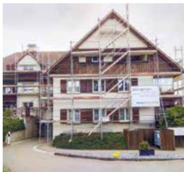
Bei einem Mehrfamilienhaus in Müllheim wurden das Mauerwerk frisch verputzt und das Holzwerk geschliffen und gestrichen.
